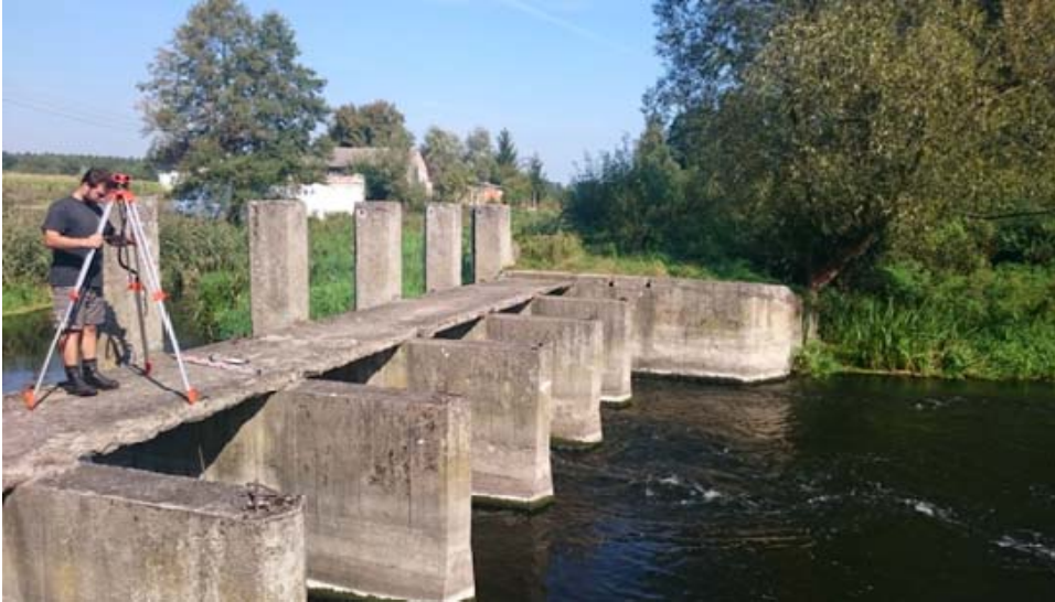
Rys. 1. Studenci kierunku IGW w trakcie pomiarów na stopniu wodnym Nowy Młyn na Welnie.
