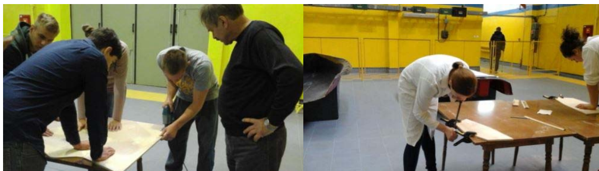
Rys. 3. Na podstawie szablonów wycinanie wręgów ze sklejki.
