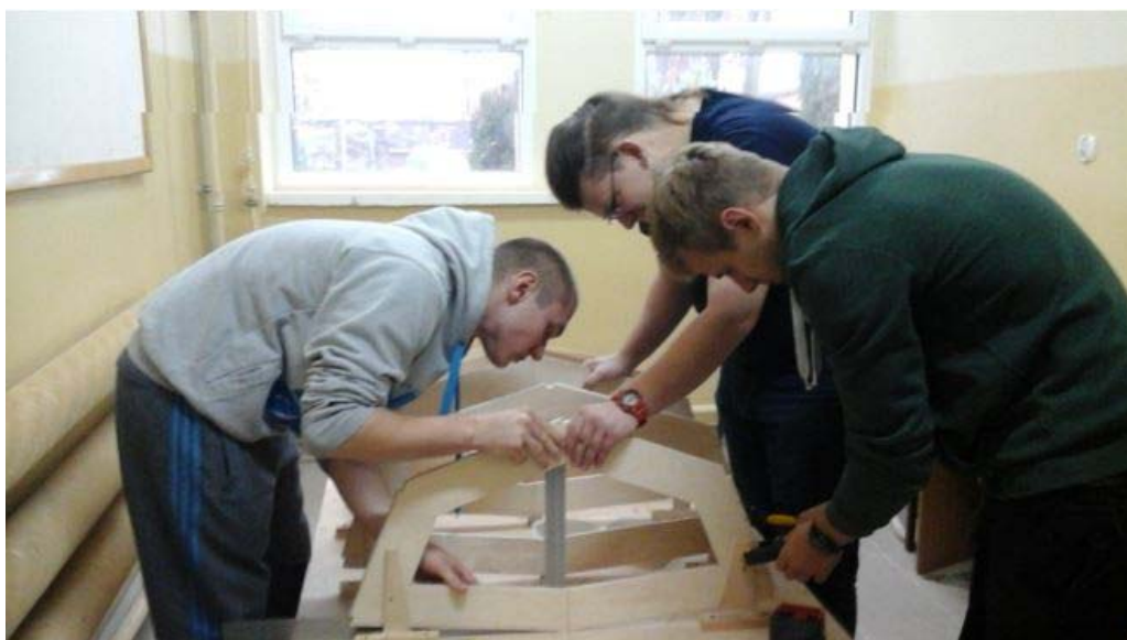
Rys. 4. Ustawianie wręgów kadłuba jachtu na stole montażowym.
