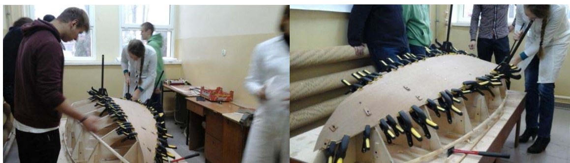
Rys. 9. Montaż poszycia dna i burt na szkielecie.
